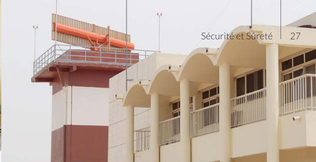
LA NOUVELLE TOUR ÉQUIPÉE DE RADAR
